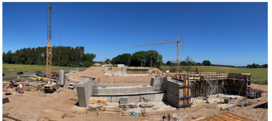
Brückenbau über die Nettelau schreitet voran. Zurzeit werden mit Hochdruck die Mittelpfeiler errichtet. (Text u. Foto: H.J.)
