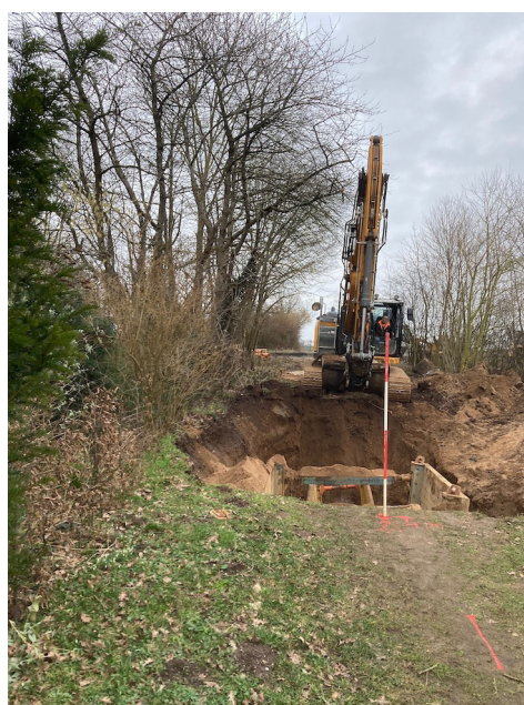
Darüber links und mitte: Graben vom Raaden durch B404 für die Schmutzwasserleitung der WC-Anlage auf dem A21-Parkplatz mit Leitung durch den Raaden bis zum Alten Bahnhof!
