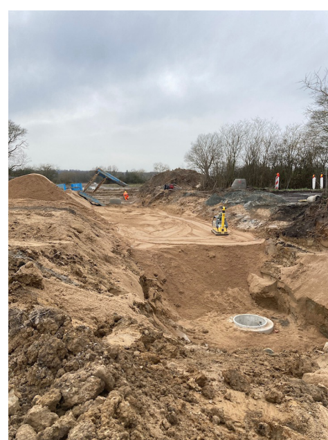
Darüber links und mitte: Graben vom Raaden durch B404 für die Schmutzwasserleitung der WC-Anlage auf dem A21-Parkplatz mit Leitung durch den Raaden bis zum Alten Bahnhof!
